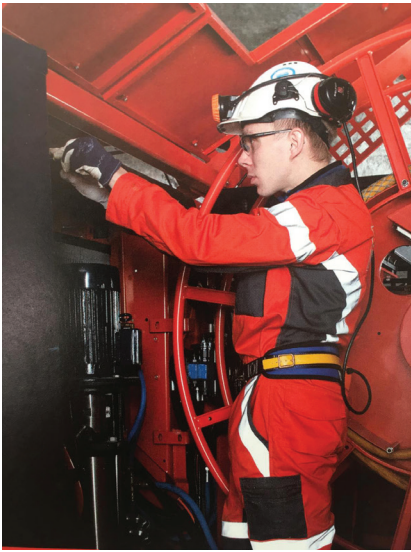
Рис. 5.20. Технічний огляд електрообладнання бурової установки шведської фірми «Atlas-Copco» S1D
